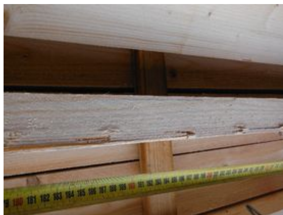
Att. 16: Padeves veltnu iespaidumu uzmērīšana.
