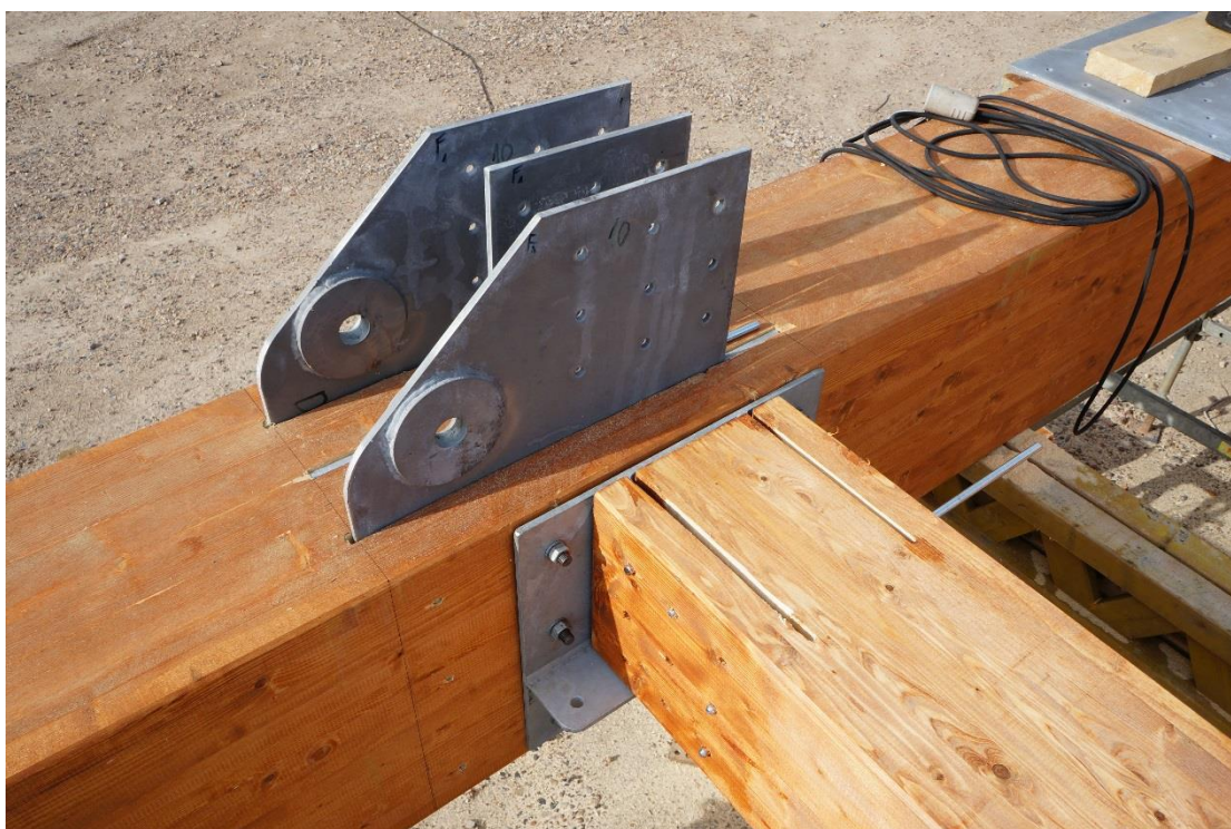
5.7. att. Tērauda elementu iestrāde kopnes mezglos.
