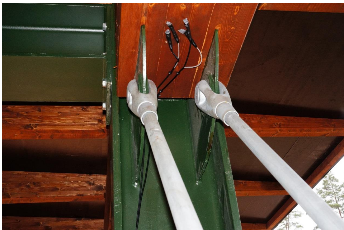
11.5. att. Mitruma mērīšanas punkti pie balsta mezglā zem jumta.
