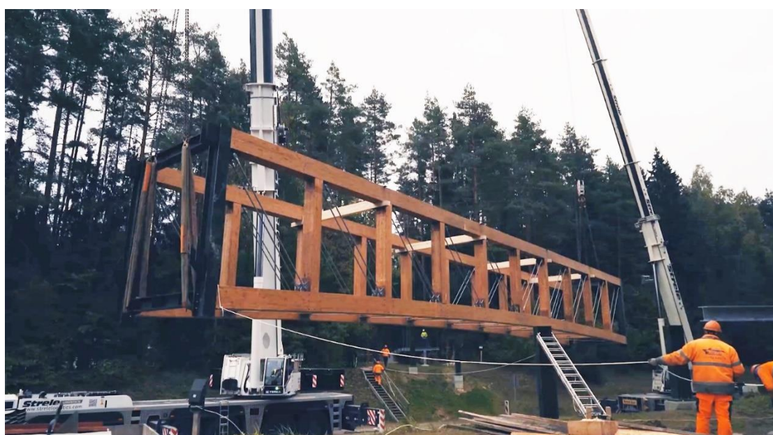
8.4.att. Konstrukcijas iecelšana laidumā.
