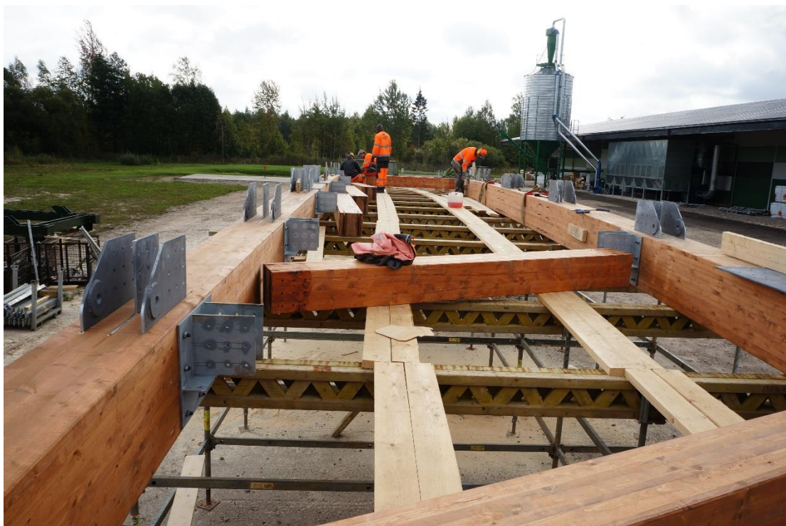
5.6. att. Tērauda elementu iestrāde kopnes mezglos.
