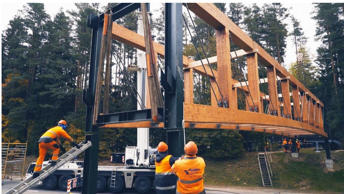
8.6.att. Konstrukcijas fiksāža projektā paredzētajā vietā.
