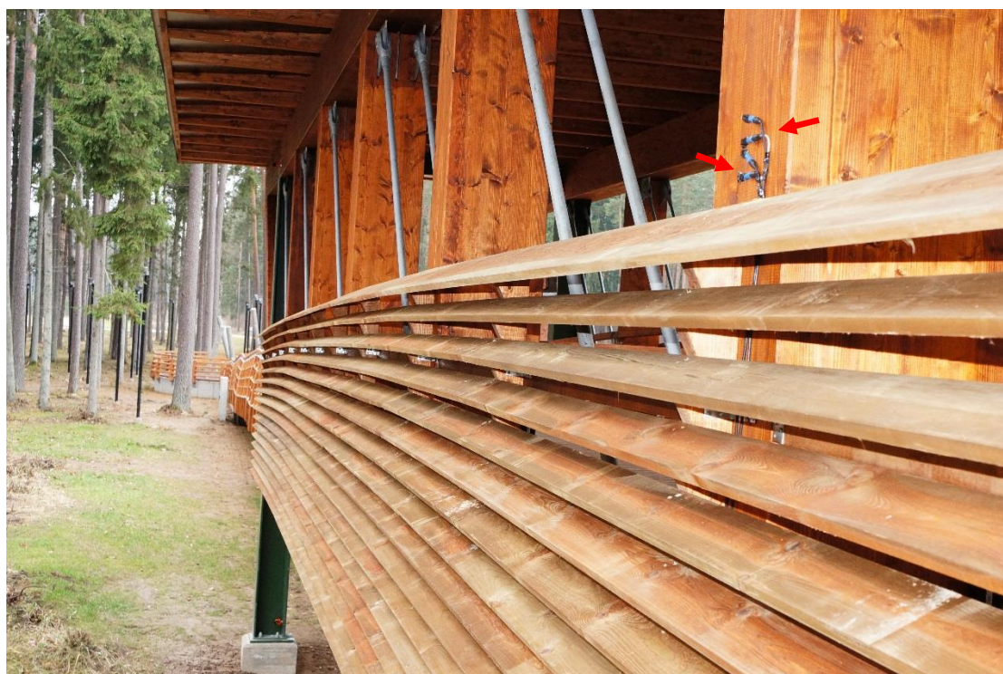
11.3. att. Mitruma mērīšanas punkti laiduma vidū fasādē.
