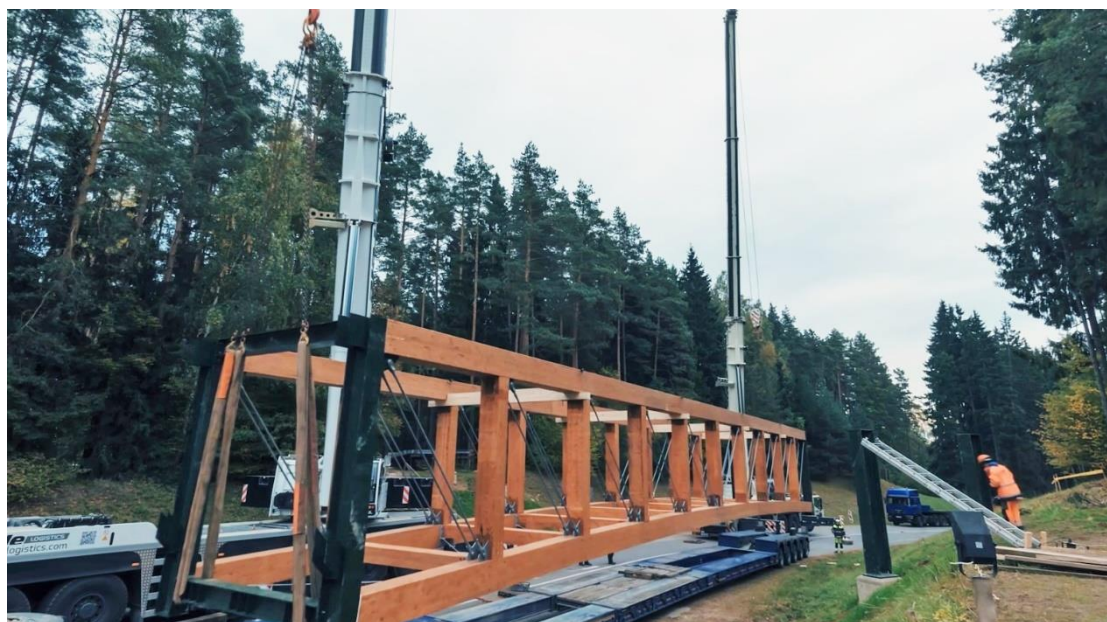
8.3.att. Konstrukcijas izcelšana no transporta piekabes.
