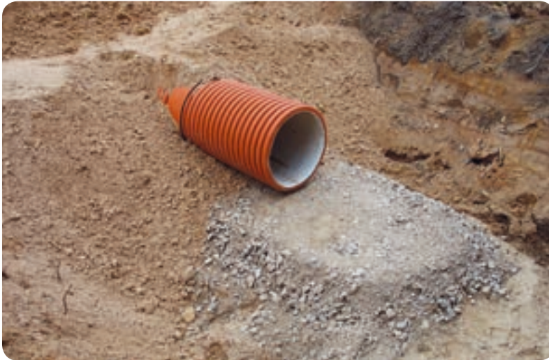
Plastmasas caurtekas iebūve uz sagatavotas pamatnes
