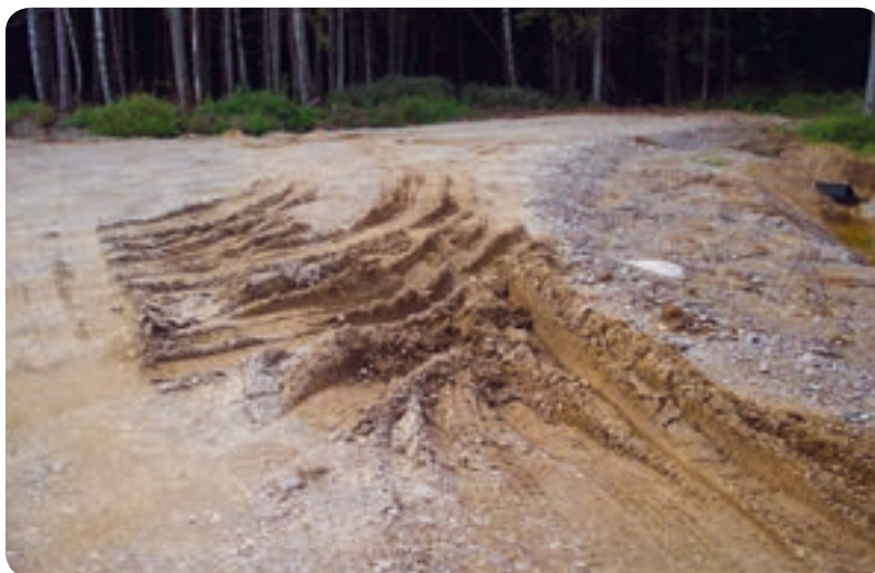
Laikus nenovērsta deformācija, izveidojusies par nopietnu defektu
