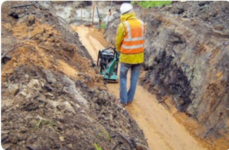
Caurtekas pamatnes bļietēšana ar vibroplati
