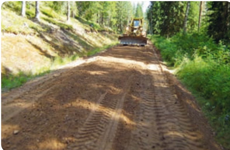
Izskalojumu novēršana veicot MAC profilēšanu
