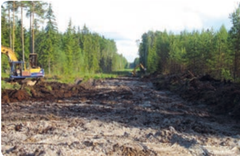
Trases atbrīvošana no celmiem ar ekskavatoru
