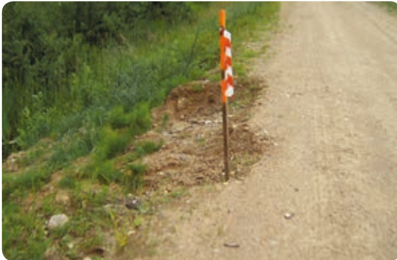
Izskalojums, kas izveidojies par bīstamu defektu
