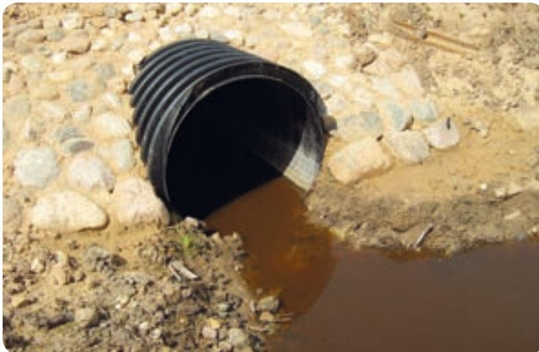
Atjaunota caurteka ar laukakmeņu krāvēju nostiprinātiem galiem
