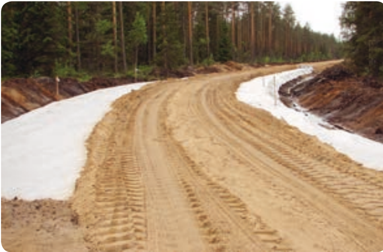
Ģeotekstils atdala smilts drenējošo kārtu un zemes klātni
