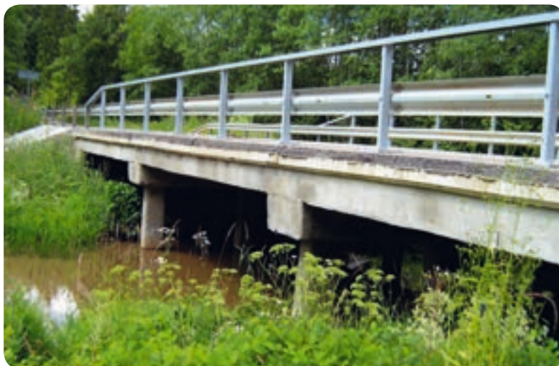
Dzelzsbetona tilts, sānskats
