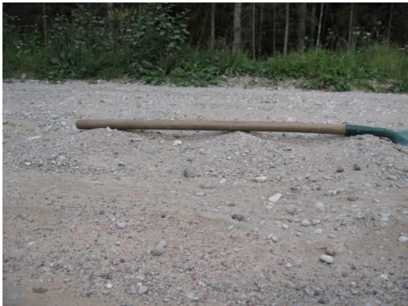
2.ATTĒLS Izžuvuša seguma deformācija – „trepe”
