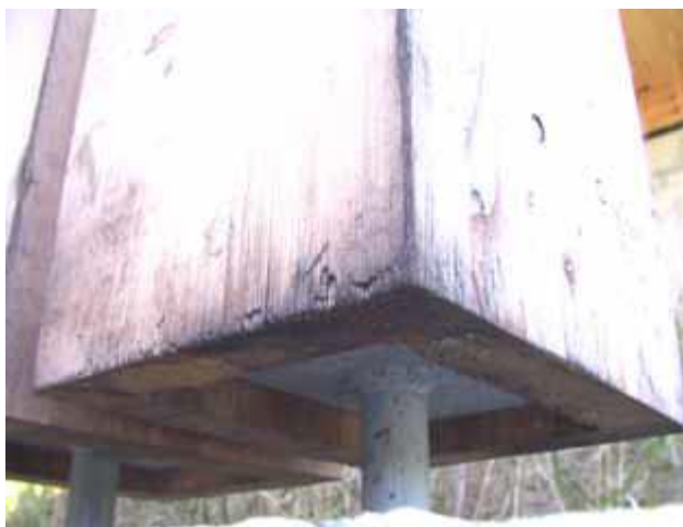
4.18. att. Koka un betona konstrukciju savienojuma piemērs [13]
