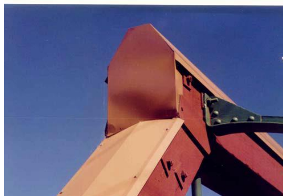
4.29. att. Koka elementa gals nosegts ar metāla plāksni [44]
