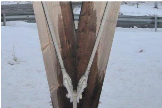
4.11. att. Neaizsargātā savienojumā uzkrājas mitrums [39]
