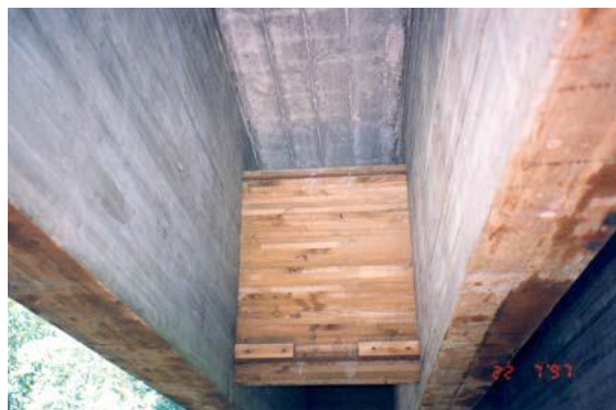
1.4. att. Līmētās koksnes siju tilts pār Vaives upi
