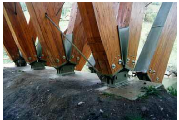
4.12. att. Savienojums aizsargāts ar metāla pārklājumu [13]
