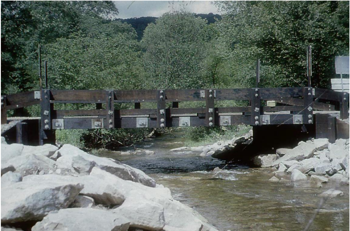
1.7. att. Saspriegtās laminētās plātnes tilts ASV [16]
