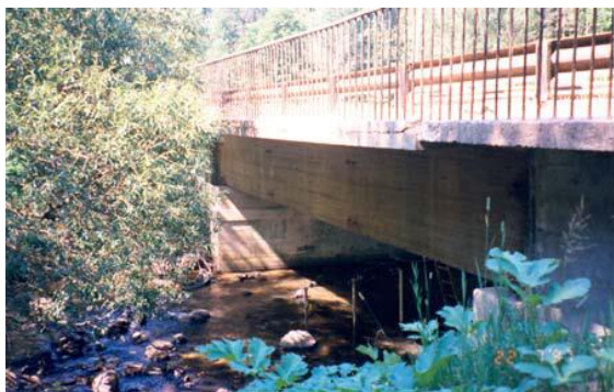
1.4. att. Līmētās koksnes siju tilts pār Vaives upi
