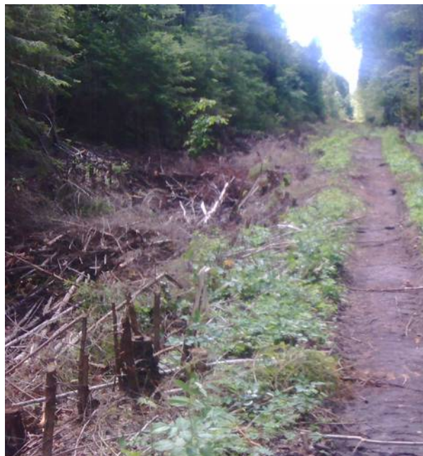
Att. 15: Atzarošanas metodes – kreisajā pusē zari un sīkkoki perpendikulāri grāvim, labajā pusē – grāvja gultnē paralēli grāvim.
