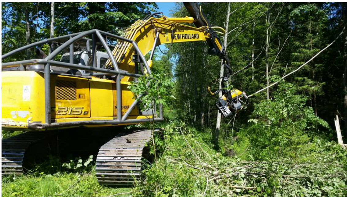
Att. 14: Atzarošana perpendikulāri grāvim.
