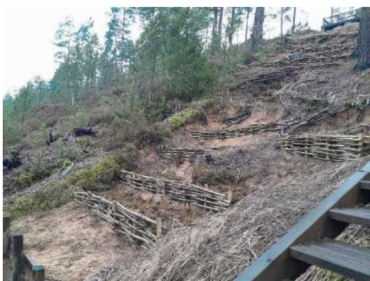
1.1.60. attēls. Erodētās austrumu nogāzes stiprinājums ar mietiņiem un klūgu pinumu. Foto: Vija Kreile, 29.01.2025.
