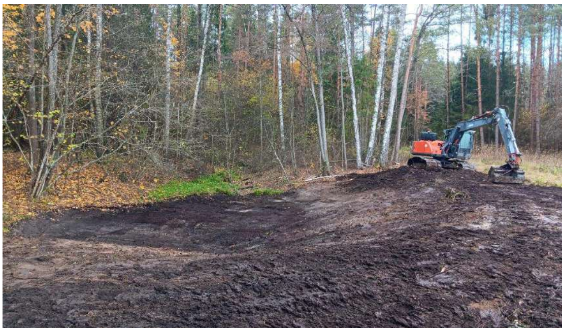
2.3.5. attēls. Dīķa atjaunošana darbu nobeiguma fāzē 117. kvartāla 37. nogabalā 2024. gada rudenī. No dīķa izrakts sedimentu un detrīta slānis veidojot seklūdens zonu vienā krastā un saglabājot neskartu dīķa pretējo krastu. Foto: Mārtiņš Kalniņš.
