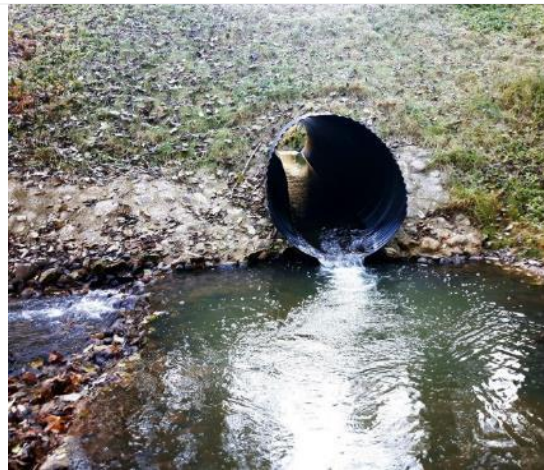
1.3.4. attēls. Karogupītes caurteka pirms akmeņu krāvuma izveidošanas. Foto Mārtiņš Kalniņš
