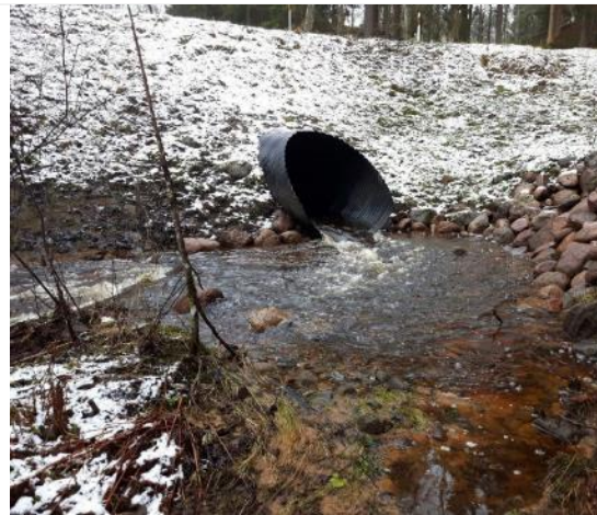
1.3.5. attēls. Karogupītes caurteka pēc akmeņu krāvuma izveidošanas. Foto Mārtiņš Kalniņš
