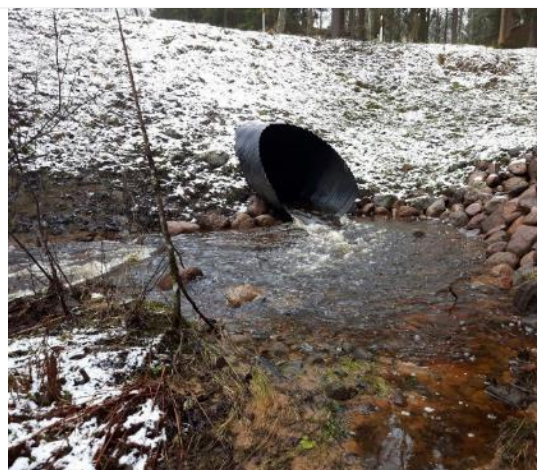
1.3.3. attēls. Karogupītes caurteka pēc akmeņu krāvuma izveidošanas. Foto Mārtiņš Kalniņš
