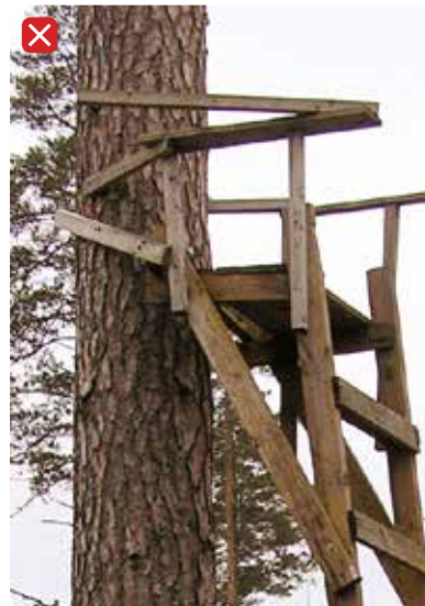
Kāpnes pienaglotas pie augoša koka. Tā nedrīkst!
