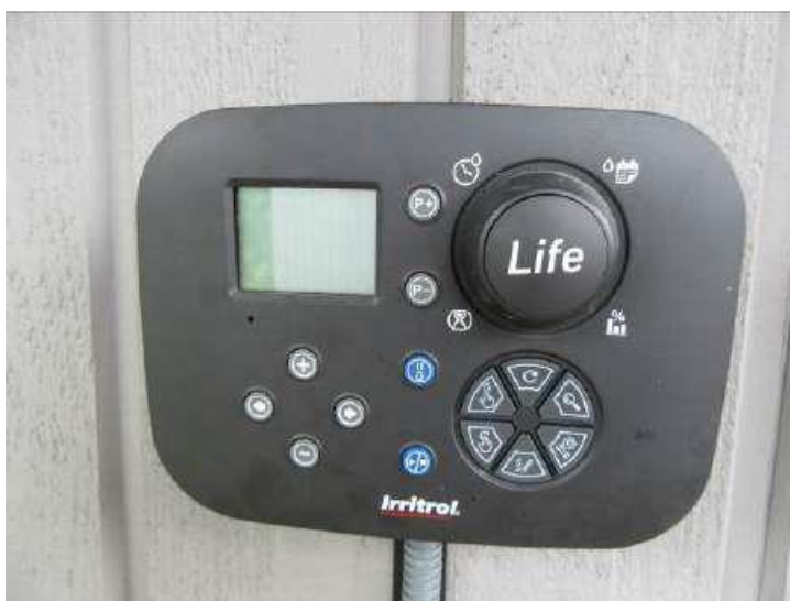
Laistīšanas sistēma (Inv. Nr. 033520) – Vadības panelis
