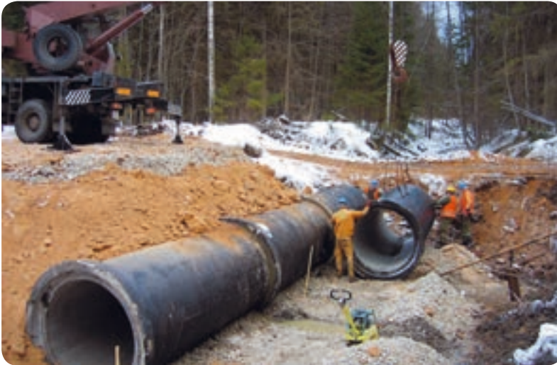
Dubultās dzelzsbetona caurtekas iebūve
