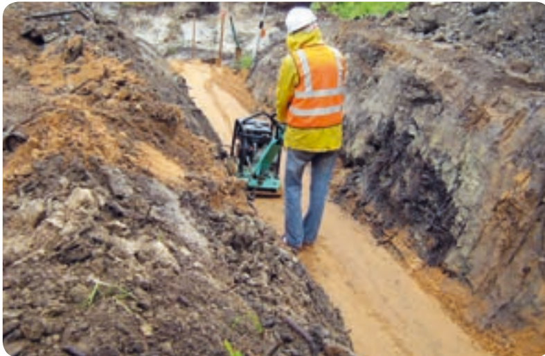
Caurtekas pamatnes bļietēšana ar vibroplati
