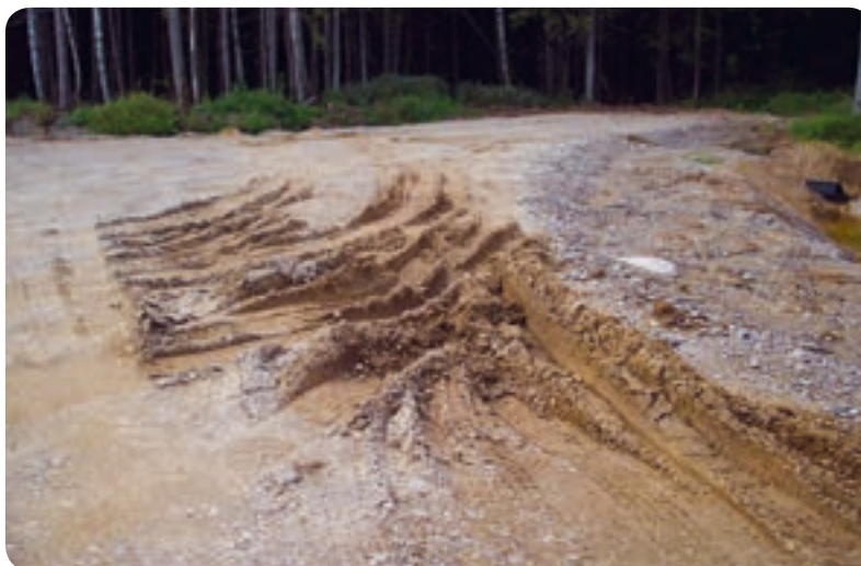
Laikus nenovērsta deformācija, izveidojusies par nopietnu defektu
