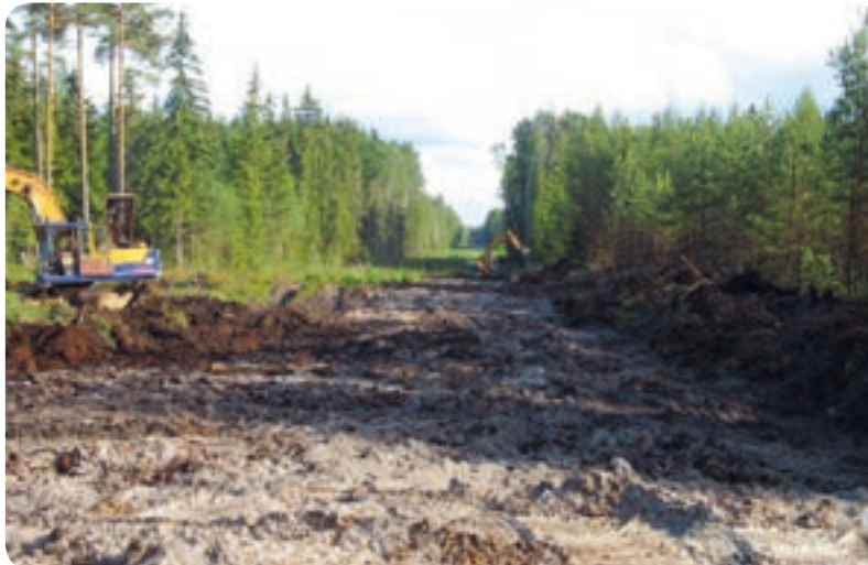
Trases atbrīvošana no celmiem ar ekskavatoru
