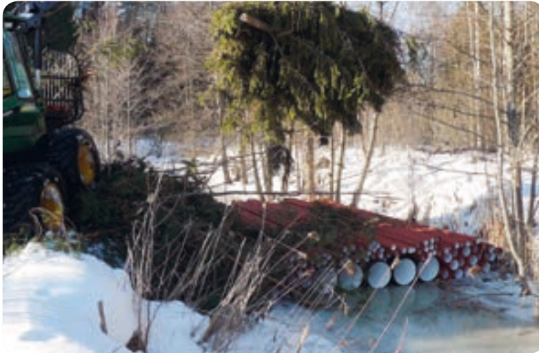
Cauruļu saišķi ūdenstecē
