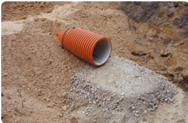
Plastmasas caurtekas iebūve uz sagatavotas pamatnes
