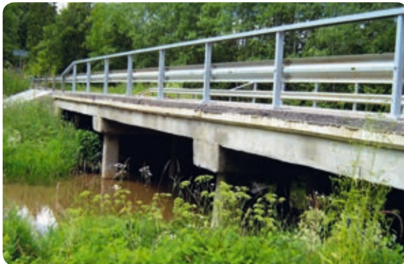
Dzelzsbetona tilts, sānskats
