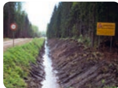
Ar pagaidu ceļa zīmēm aprīkots būvobjekts
