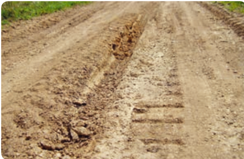
Izveidojusies deformācija
