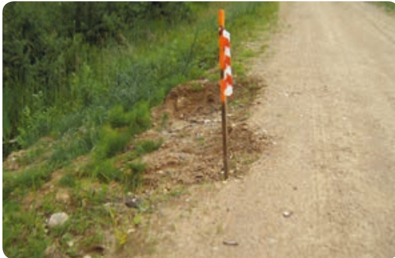
Izskalojums, kas izveidojies par bīstamu defektu
