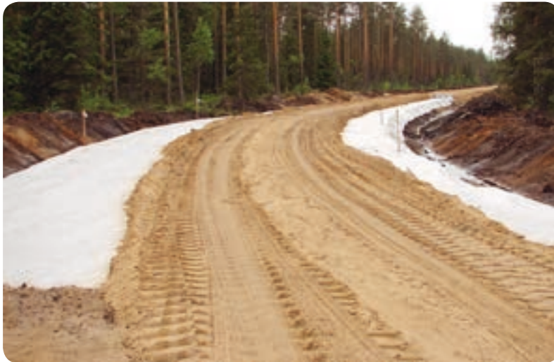
Ģeotekstils atdala smilts drenējošo kārtu un zemes klātņi
