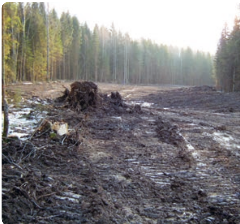
Ar buldozeru atbrīvota ceļa trase
