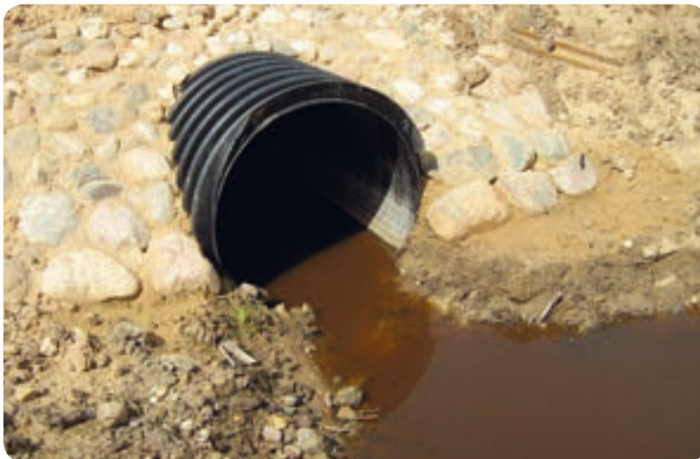
Atjaunota caurteka ar laukakmeņu krāvēju nostiprinātiem galiem
