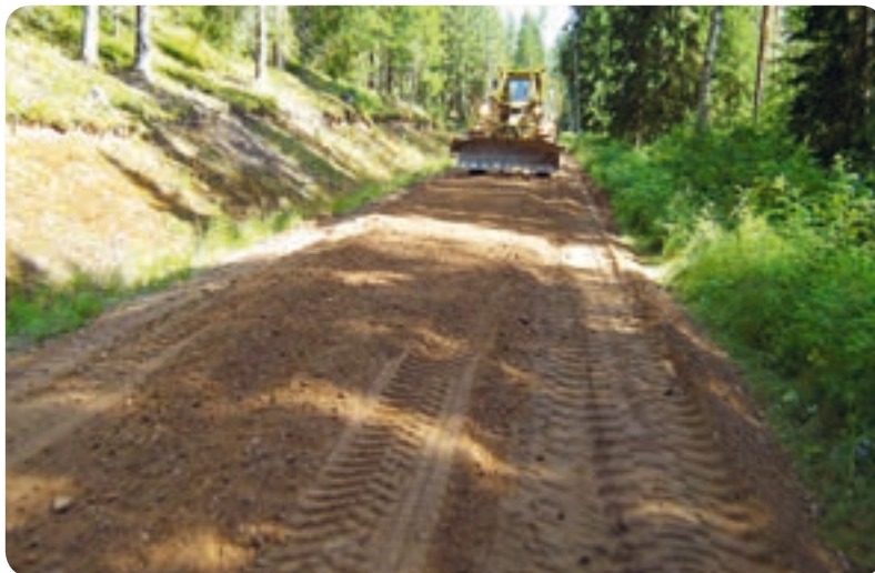
Izskalojumu novēršana veicot MAC profilēšanu
