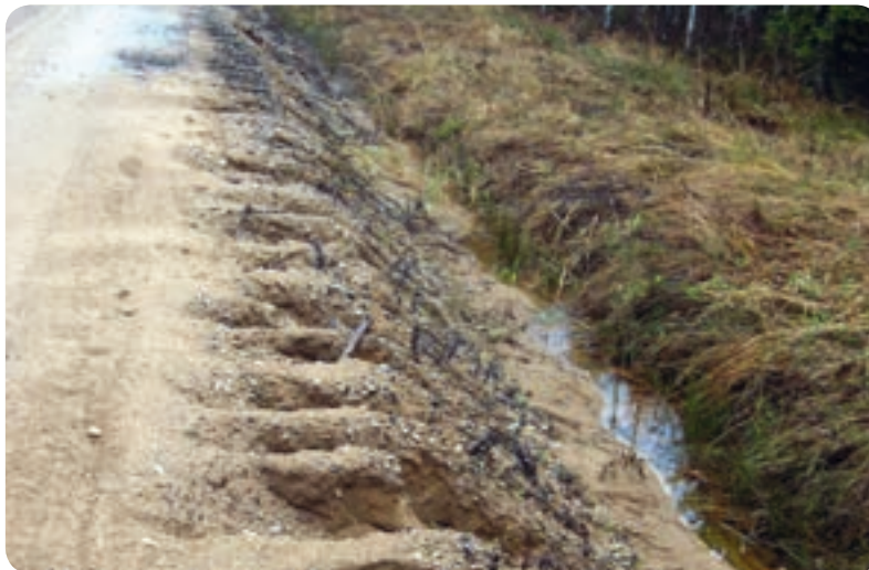
Izskalojumi uz meža autoceļiem
