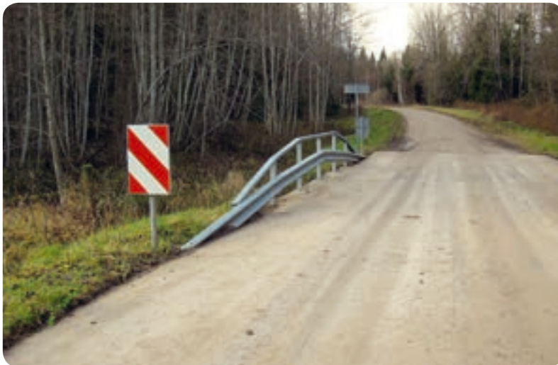
Notīrīta tilta brauktuve
