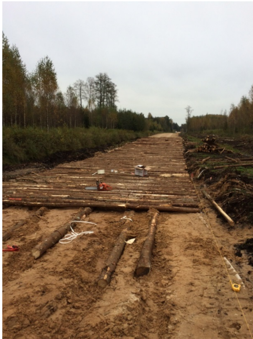
31. Attēlā 2A Tips baļķu klājums uz garenvirziena baļķiem
