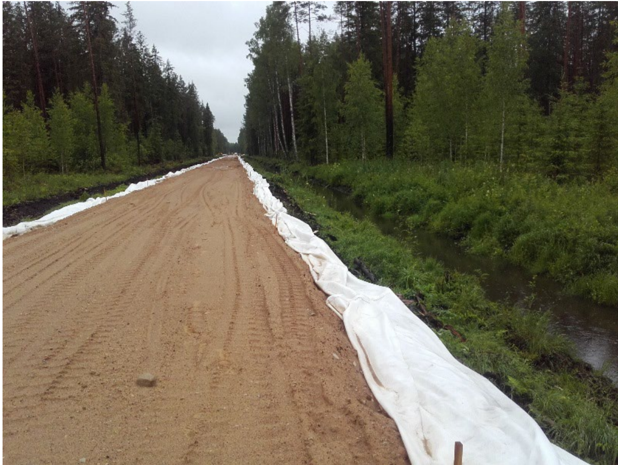
29. Attēlā 1. Tips daļēji izbūvēts ģeotekstila maiss uz kūdras
